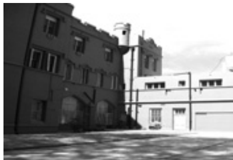
Vista de la fachada de la Misión
