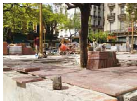
Plaza Dorrego, en obra
