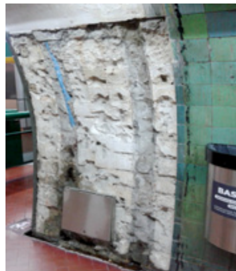
Trozo de pared con las cerámicas "levantadas"
