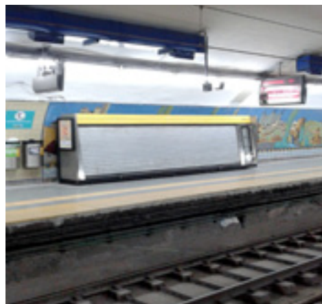
Enorme kiosco de diarios/revistas que tapa, prácticamente, toda la obra
